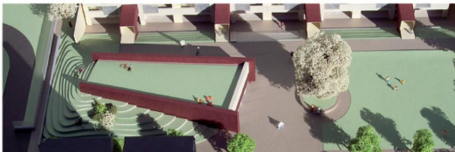
Plastico del nuovo edificio "La casa passiva ecocompatibile" in via Roma, progettato con le nuove tecnologie per il risparmio energetico. Nella foto sotto: vista dall'alto della costruzione destinata ai servizi, pensata con la copertura verde calpestabile
