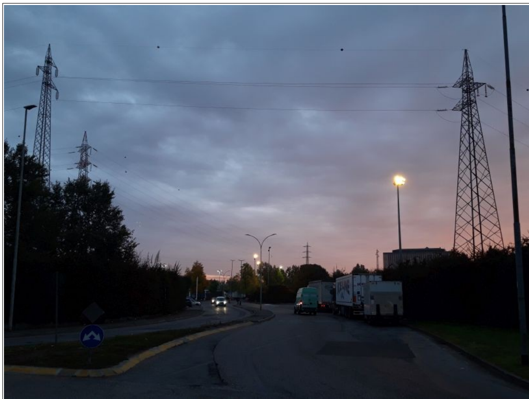
Fig. 4 – Linea aerea elettrica con altezza da terra superiore a 5,00m v.Giambologna
