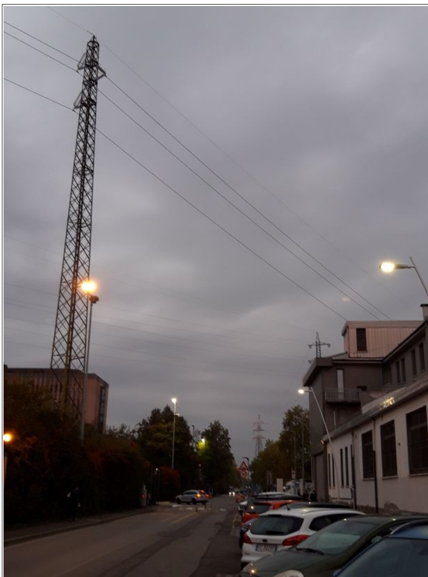
Fig. 5 – Linea aerea elettrica con altezza da terra superiore a 5,00m v.Giambologna
