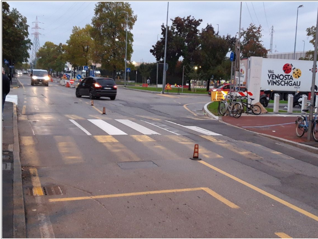
Fig. 6 – Attraversamento pedonale rialzato in carreggiata v.Giambologna (H = 0,15 m)
