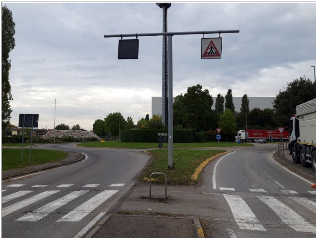
Fig. 1 – Attraversamento pedonale a raso con segnaletica verticale in carreggiata v.Grandi (H = 5,20 m)
